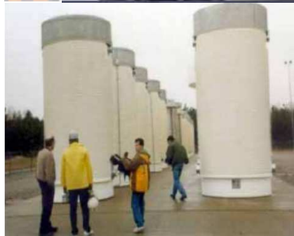
Almacenamiento temporal centralizado de residuos de alta actividad
